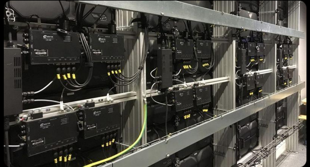
Netzteile, Screen Controller und Datenkabel hinter der Wand: Eingriffe nur spannungsfrei und durch Fachpersonal.
